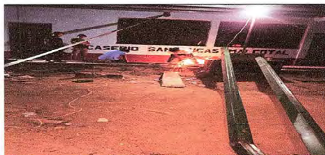
Foto 6: realizacion de cambio de las costaneras del establecimientos.
